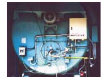
รูปที่ 2.2 แสดงการติดตั้งอุปกรณ์ชุดควบคุมอากาศในการเผาไหม้
