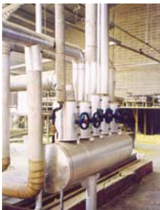
รูปที่ 1.1 ภาพแสดงระบบท่อและผ้มังดาที่มีการหุ้มฉนวน (บริษัท สหฟอสซิลอินดัสตรี จำกัด)
