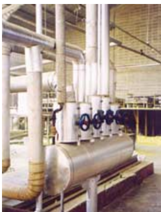
รูปที่ 1.1 ภาพแสดงระบบท่อและผนังเตาที่มีการหุ้มฉนวน (บริษัท สหฟอสซิลอินดัสตรี จำกัด)
