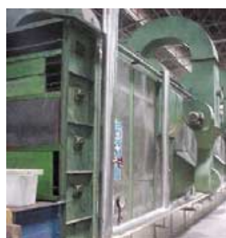
รูปที่ 2.1 แสดงท่อส่งไอน้ำภายใต้การหุ้มฉนวน (บริษัท ยูเนี่ยนราชนบุรี (1992) จำกัด)
